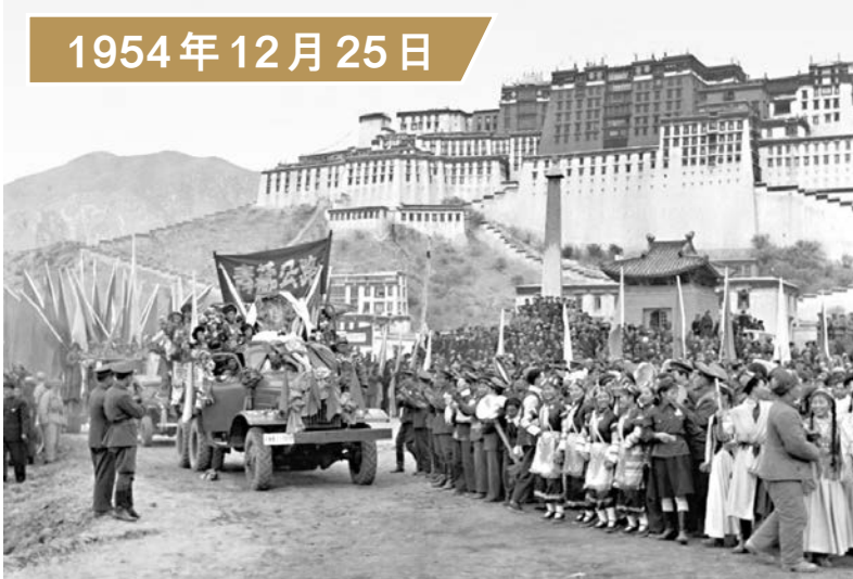
1954年12月25日 兩條當時世界上海拔最高的公路——川藏（又稱康藏）公路和青藏公路同一天全線通車，結束了西藏幾千年來不通公路、沒有汽車的歷史。
